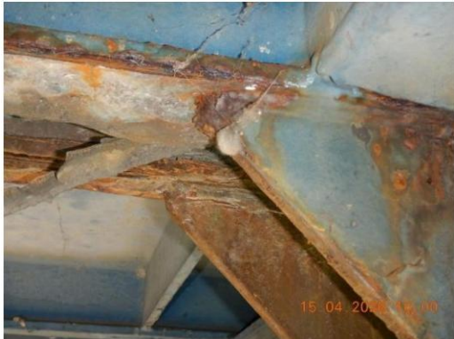
Foto 1: Corrosie sectie-einden
