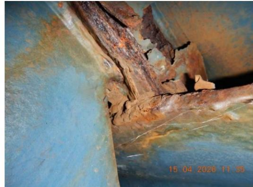
Foto 2: Corrosie sectie-einden
