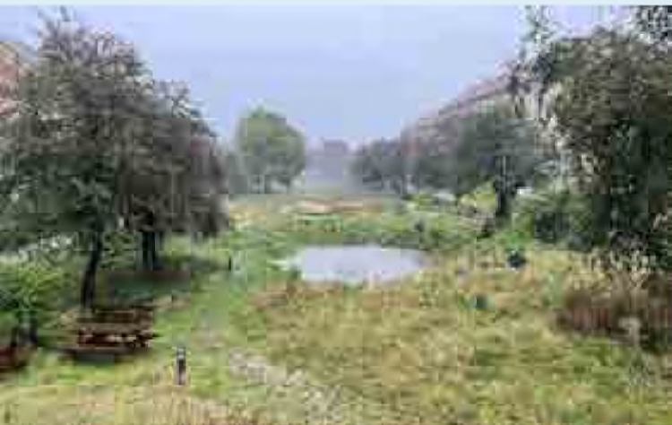
Afbeelding 122 & 123. Groningen-Bispeparken, Kopenhagen (2024) SLA. Achttien speciaal ontworpen bassins ondersteunen bij droog weer activiteiten van bewoners en functioneren bij hevige regenval als waterbuffer, met een gezamenlijke capaciteit tot 3.000 m 3 regenwater. Het park is bovendien ontworpen met beplanting, bomen en wadi's die wateroverlast helpen voorkomen en tegelijk de lokale biodiversiteit versterken. Ontwerp: SLA. Foto's: Marie Damsgaard
