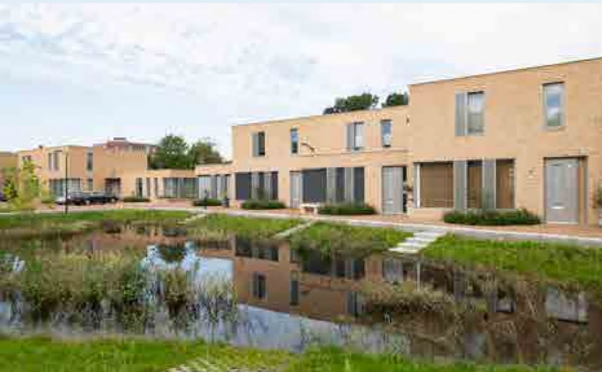
Afbeelding 118. Bachmanhof (2024) in Breda transformeert een voormalig braakliggend, binnenstedelijk, terrein tot een groen en klimaatbestendig woonhof. De collectieve buitenruimte combineert verblijfskwaliteit met waterberging, biodiversiteit en schaduwrijke beplanting. Ontwerp: DAT architecten. Landschapsonwerp: REDD. Foto: Koen van Damme.
