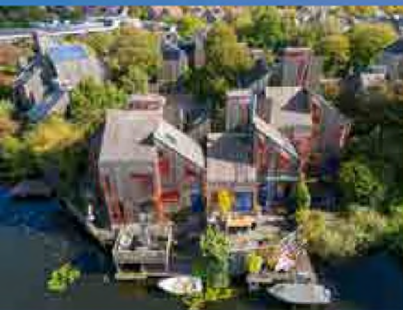
Afbeelding 29. De Vier Vierkanten Alkmaar (1979, Abe Bonnema). Een experimentele woonbuurt met modulaire houtskeletwoningen rond groene erven. Compacte woningen met verschillende oriëntaties op erf, water en groen. Het toont hoe experimentele bouw, flexibiliteit in de woningplattegrond en een zorgvuldig ontworpen openbare ruimte samen een eigentijds woonmilieu vormen. Foto: Stichting Experimentele Woningbouw, Erfgoed Alkmaar.
