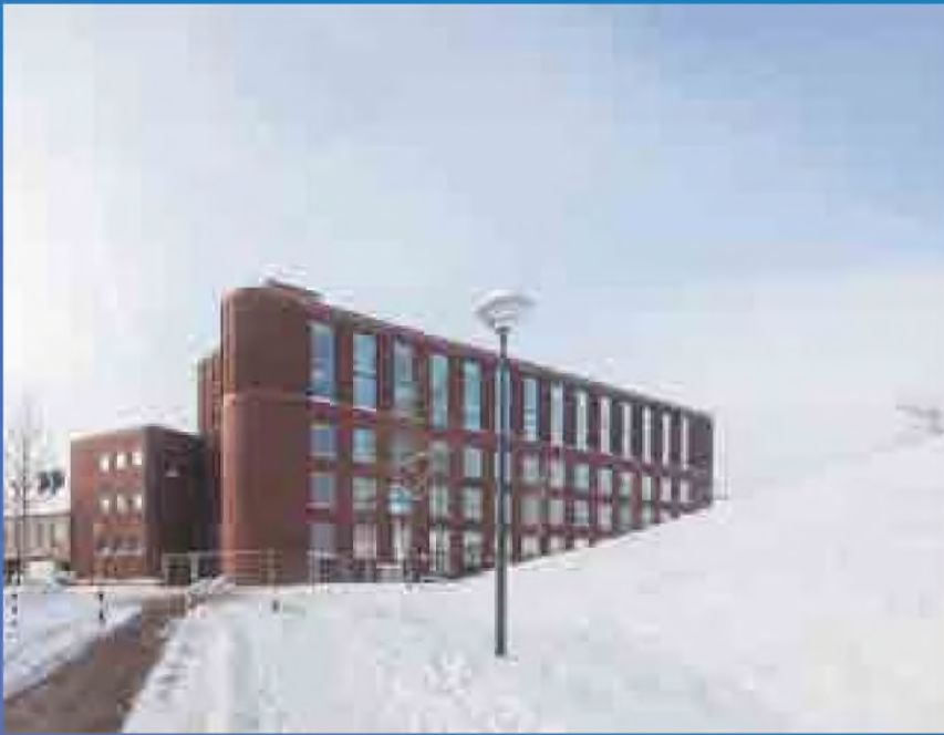
Afbeeldingen 34 & 35. Aan de noordrand van De Groene Loper in Maastricht vormt Miller II (2024) een schakelpunt tussen de bestaande wijk Wyckerpoort, en de openbare ruimte bovenop de A2. Het uit rood baksteen opgetrokken volume, met daarin 38 appartementen, schermt de achterliggende wijk af van geluid. Accenten zijn uitgevoerd in een rood geglaazuurde steen. Ontwerp: Martens Willems architecten. Foto: Arjen Schmitz.
