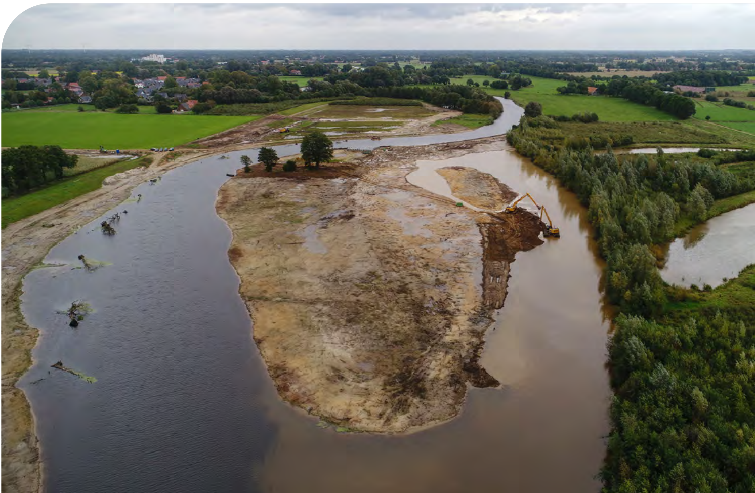
Aanleg grensmeander bij de grens met Duitsland in de Overijsselse Vecht. Foto: droneteam waterschap Vechtstromen
